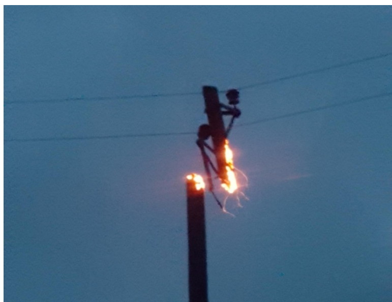
Slika 1. Gorenje glave stupa u uznapređevaloj fazi
