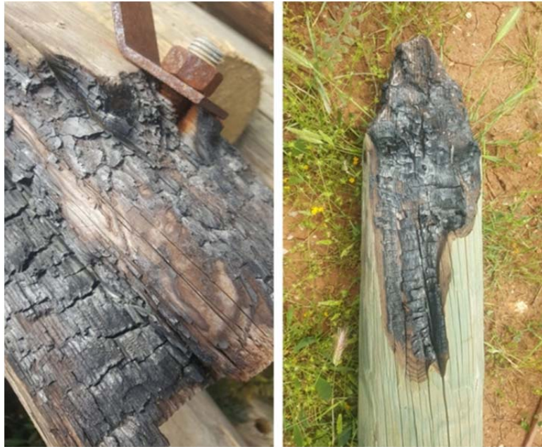
Slika 2. Zapaljeni dijelovi drvenog stupa
